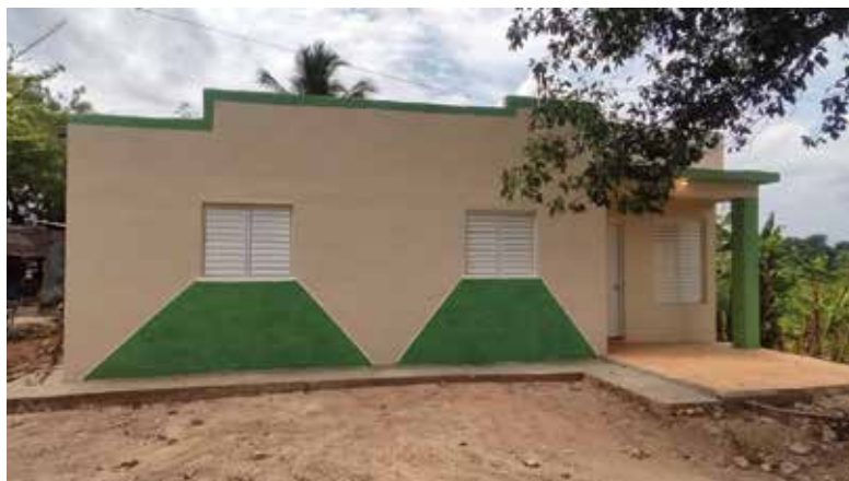
Construcción de nueva vivienda
