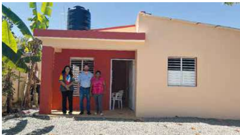
Construcción de nueva vivienda
