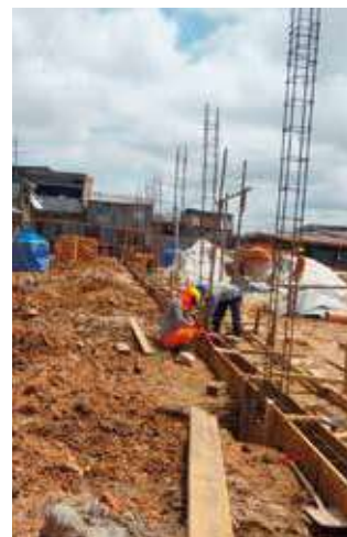
Construcción del centro de menores en Masusa
