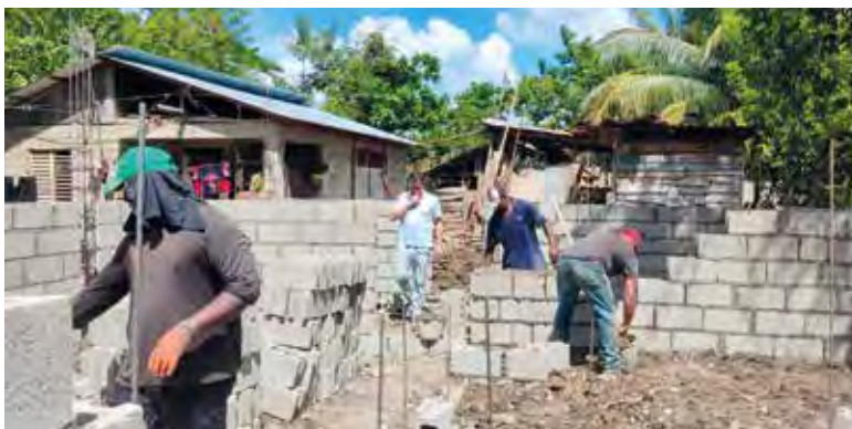
Construcción de nuevas viviendas
