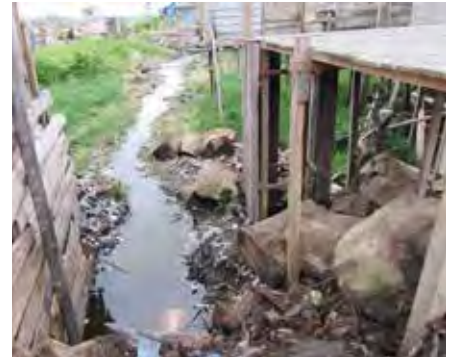
Desagüe contaminando las aguas de Iquitos
